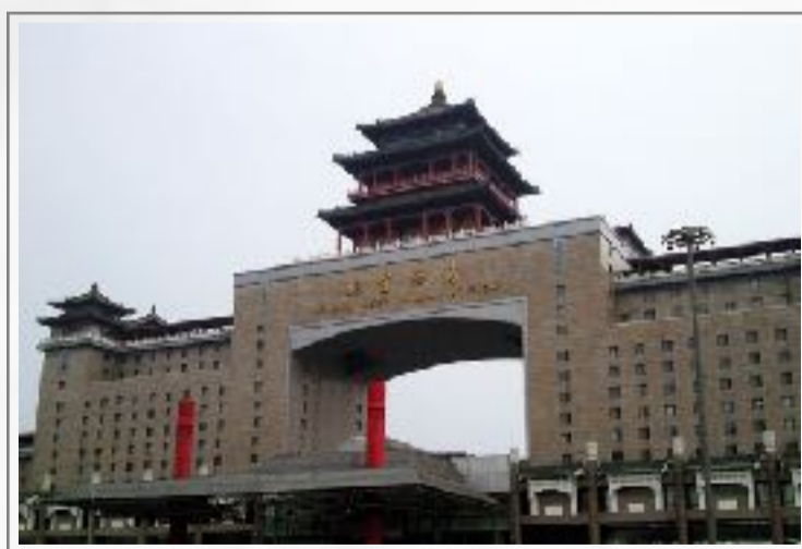
图片 3大屋顶风格：北京西站，1996。 https://upload.wikimedia.org/wikipedia/commons/c/cf/North_house_of_Beijing_West_Railway_Station.jpg
